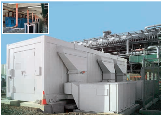
Монтаж в передвижном модуле Portable Station Module
